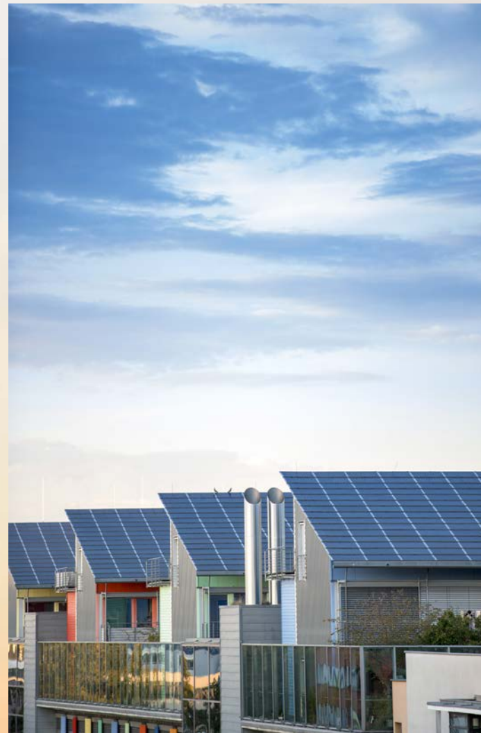
Das Sun-Ship-Gebäude in Freiburg
